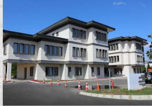
15 Temmuz Köprüsü Karakol Binası
