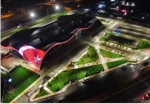
Trabzon Otobüs Terminali
